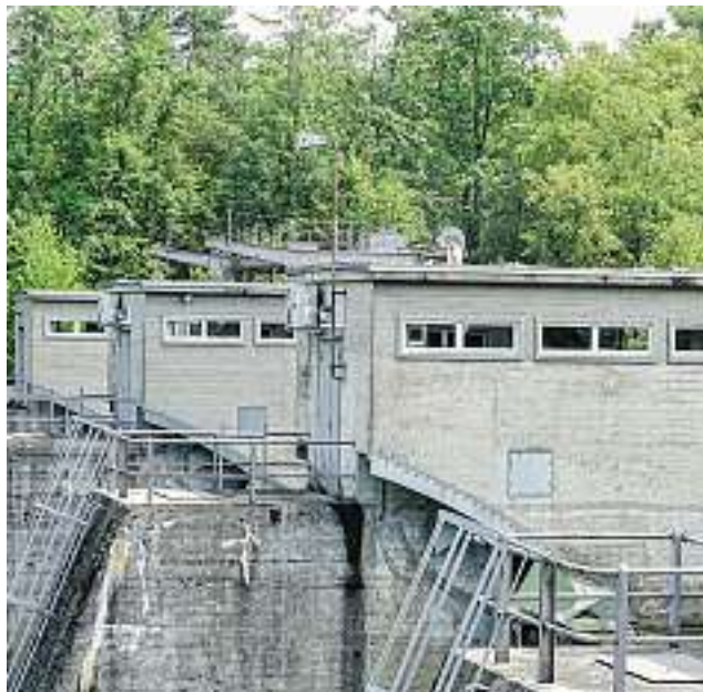
Die Flusseeeschwalben werden zum Brüten auf den Flachdächern der Stauwehr-Pfeiler animiert
