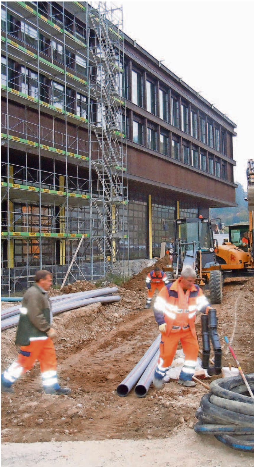
Das neue Reisezentrum in Windisch hat eine Holzfassade.
